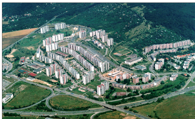
Obr. 2 Komplexní regenerace bytových domů na sídlišti Brno-Nový Lískovec
