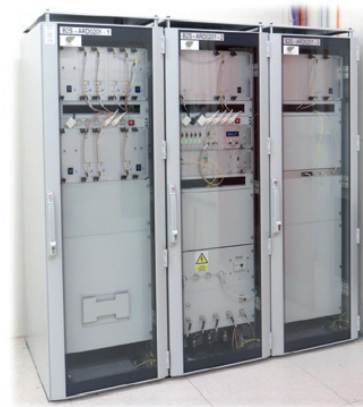
Obr. 7 Technologie ZPPRS jednoho ze stanišť tunelového komplexu Blanka
